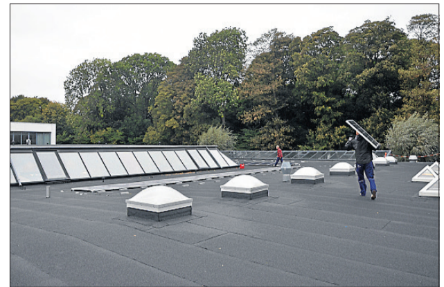
Mariagerfjord Gymnasium i Hobro producerer masser af solenergi på sit tag. Privatfoto
